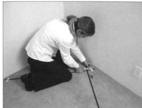
*Podemos ver na foto ao lado as duas primeiras faixas norte/sul e o primeiro cruzamento da faixa leste/oeste, sempre colando as fitas com fita crepe, o que permitirá sua remoção posterior sem danificar o piso local. As fitas de tecido podem ser reaproveitadas para uma próxima mensuração.*
